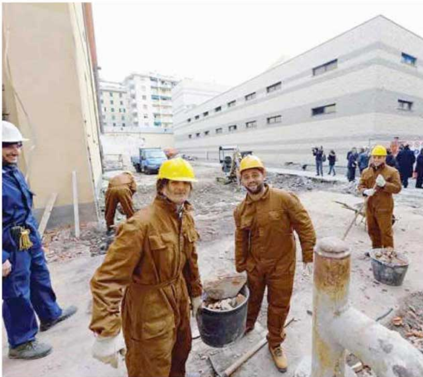
Detenuti (in tuta marrone) al lavoro nel cantiere del Teatro dell'Arca
